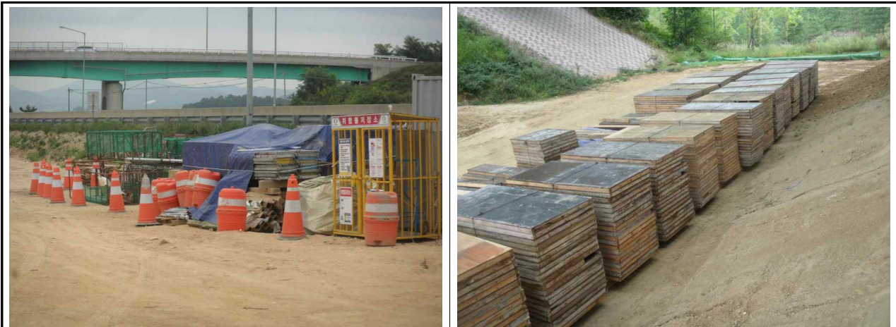
현장 내 자재보관 상태
